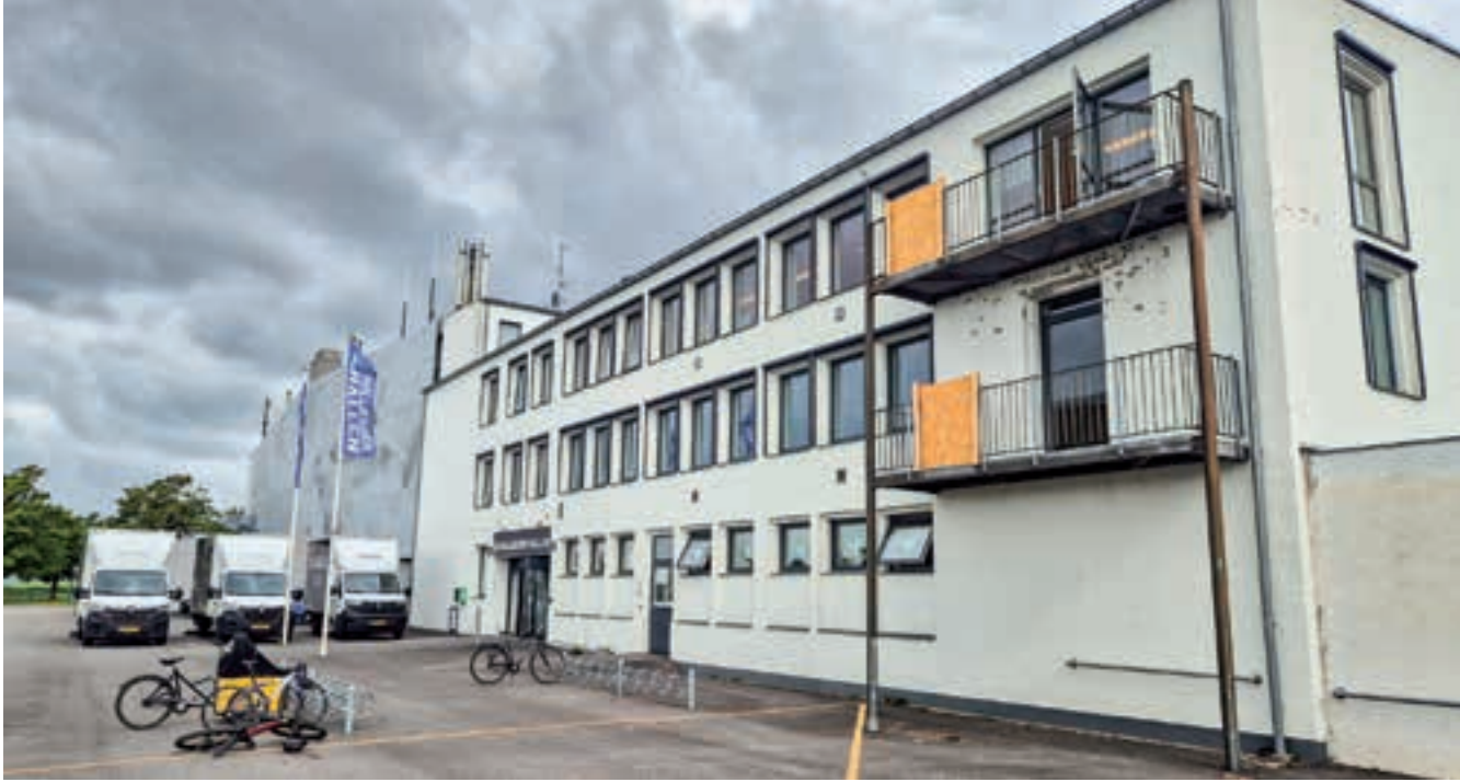
Det har været nødvendigt at etablere en ny brandtrappe i Hollænderhallen, og den skal stå klar en af de kommende uger. Ind til videre har man etableret og fået godkendt en indvendig brandtrappe. Foto: Tim Panduro
