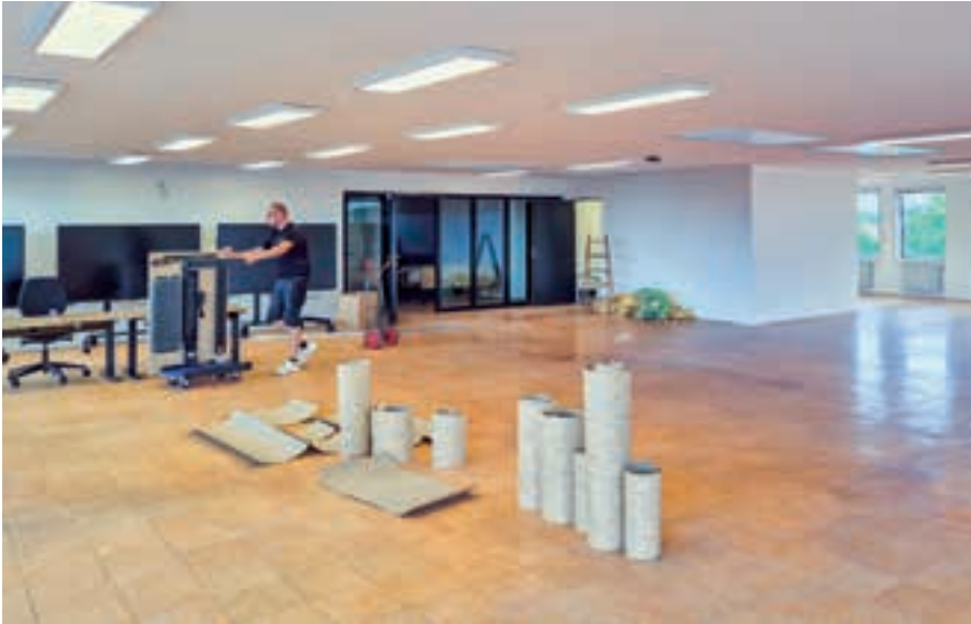
Det er kun 150 kvadratmeter af det samlede areal på 380 kvadratmeter i det nye specialundervisningstilbud, der endnu er åbnet i Hollænderhallen. Indretning og sikkerhed skal selvfølgelig på plads. Foto: Tim Panduro
